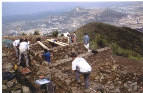
Trabajos de consolidación de estructuras de las casas de tipo simple de la calle 1.
